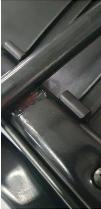
Imagem 11 – solda de travessa sob assento em detalhe vista 1
