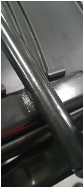
Imagem 14 – solda de travessa sob assento em detalhe vista 4
